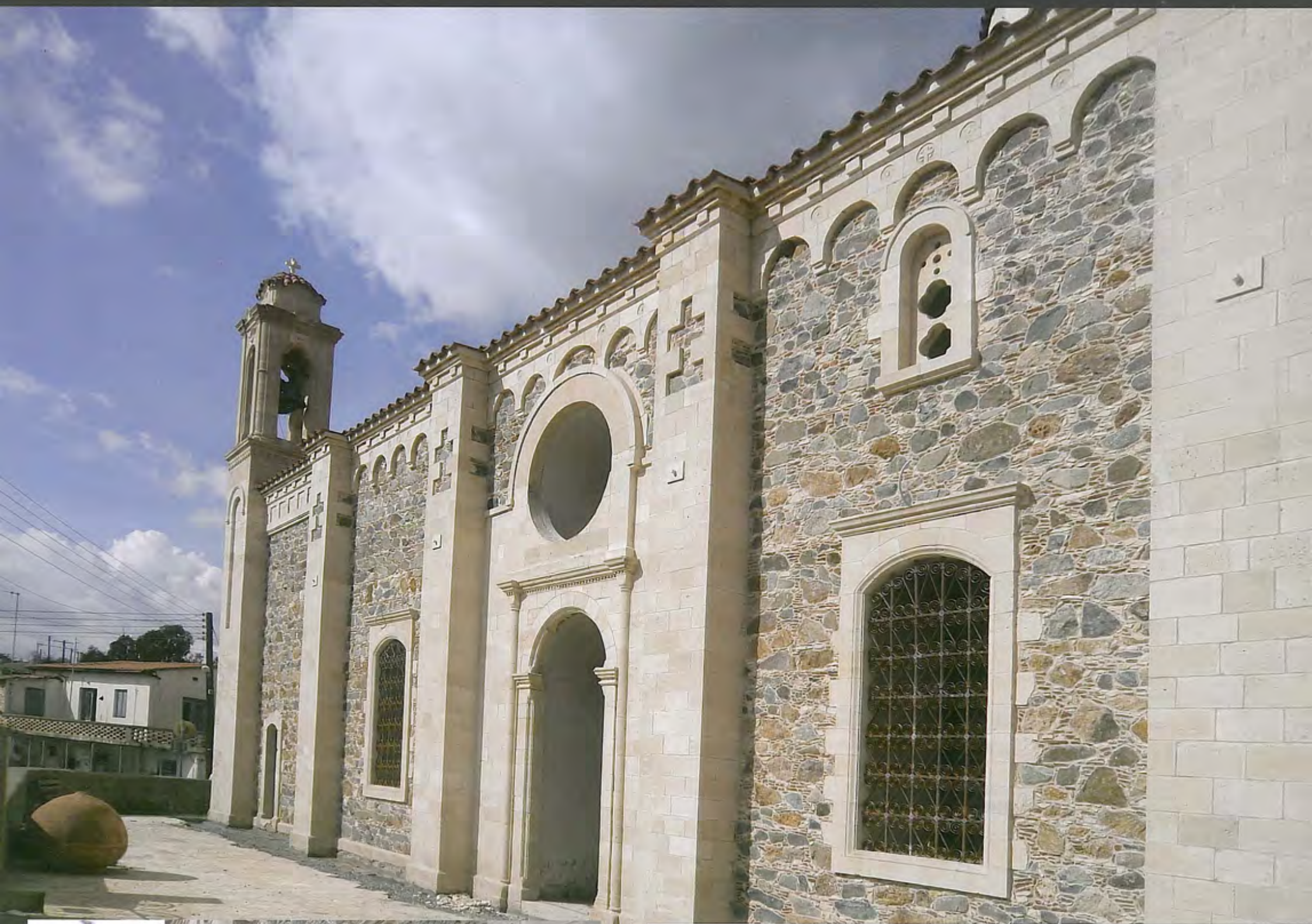
Εκκλησία Αγίας Μαρίνας - Υπό ανακαίνιση
